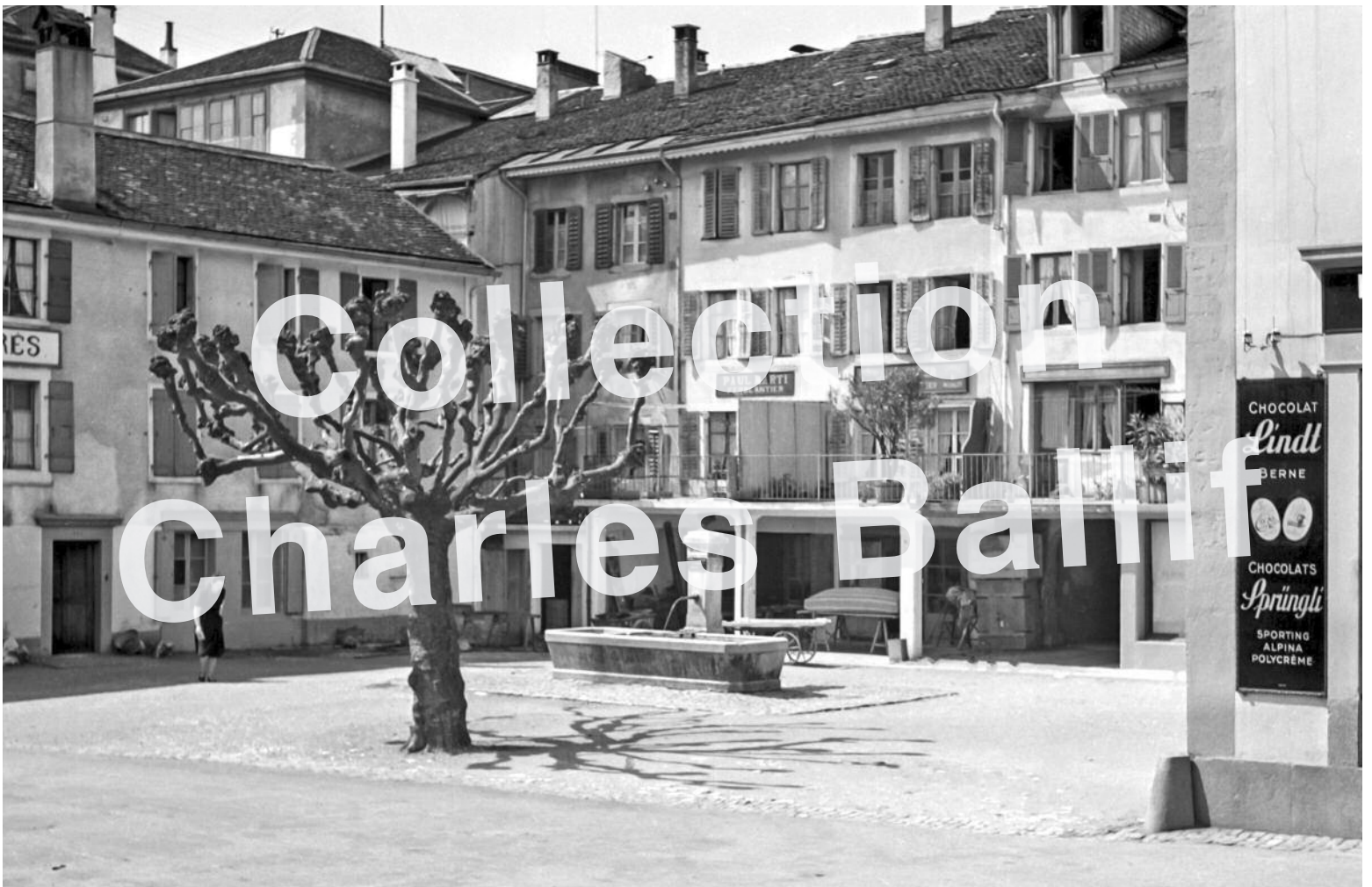
La Neuveville 1940, les Courtines-rue de la Gare. (Collection Charles Ballif)
