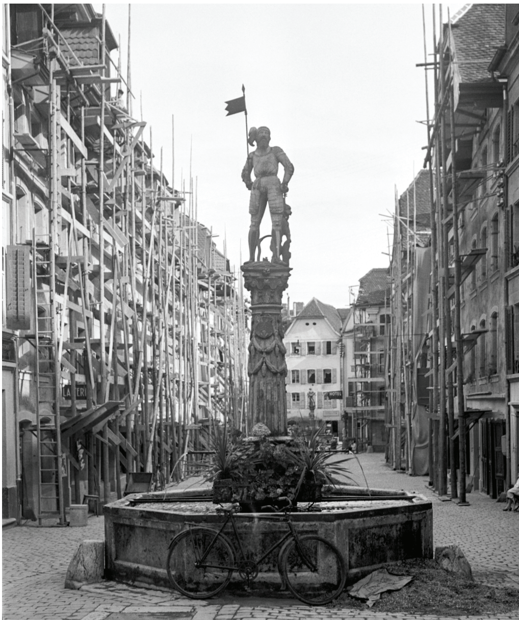
La Neuveville, 1936, Rue du Marché – Restauration des facades (collection Charles Ballif)
