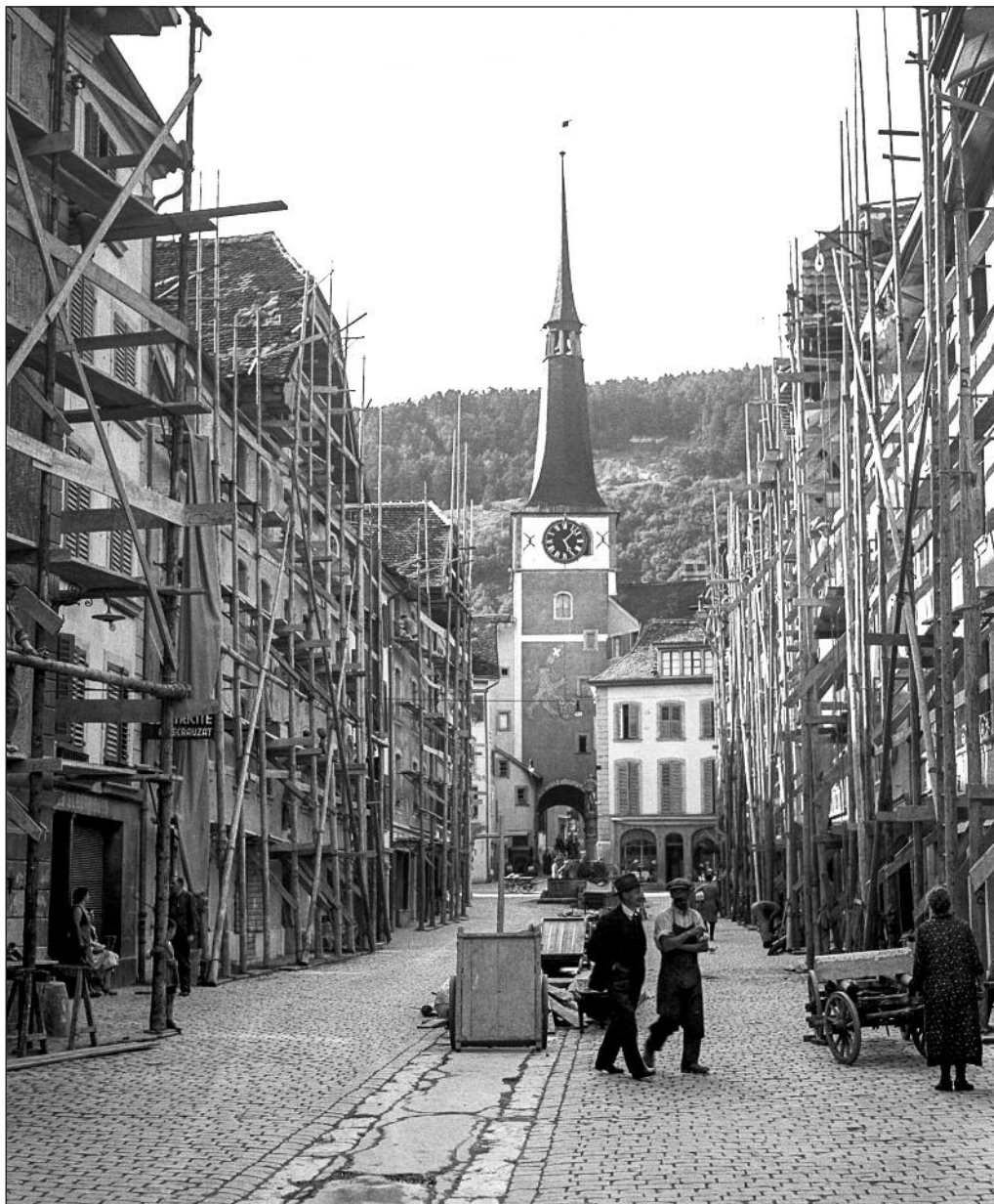
La Neuveville 1936 - Rue du Marché, rénovation des façades. (Photo A. Acquadro - Coll. Ch. Ballif)
